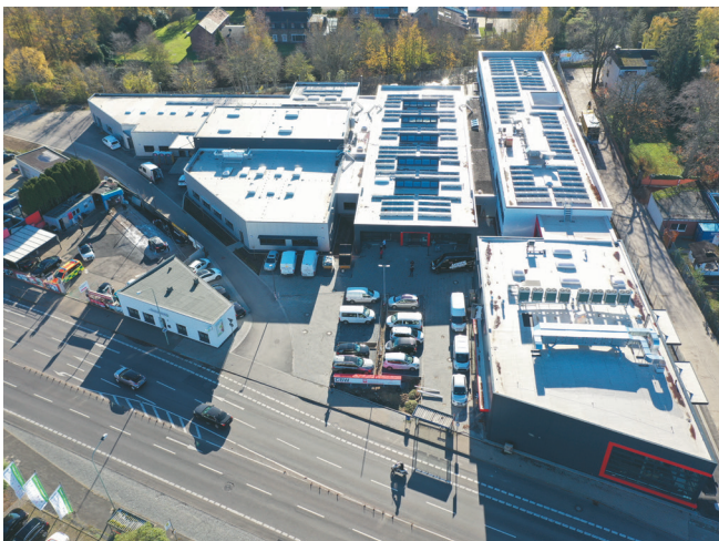
Caritas Betriebs- und Werkstätten GmbH headquarters in Eschweiler, Germany
